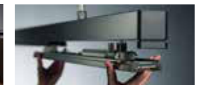
3 Einclick-Montage der Lichtträger
